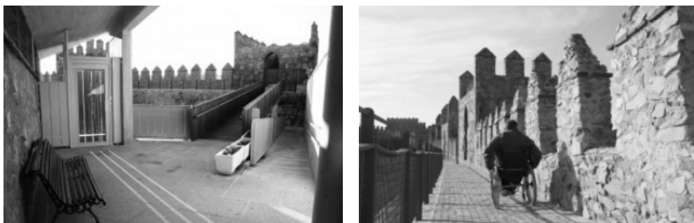
Ryc. 2. Mury miejskie dostosowane do potrzeb osób niepełnosprawnych
