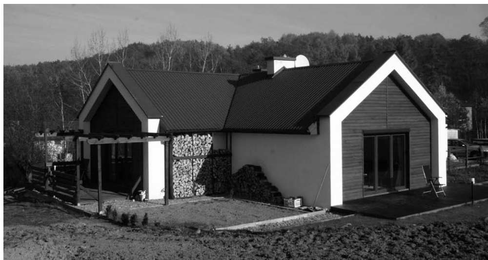
Fot. 2. Przykład realizacji domu jednorodzinnego z prefabrykowanych bloków ze spienionego polistyrenu (neoporu), Wieliczka koło Krakowa
