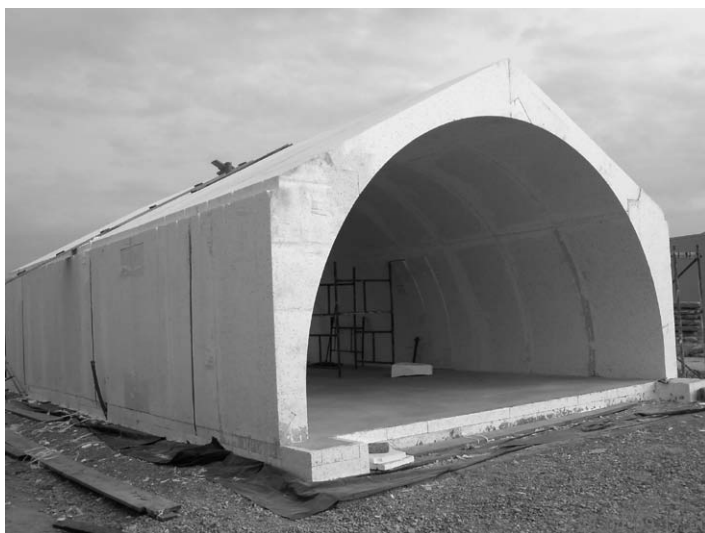
Fot. 1. Etap konstrukcji domu z prefabrykowanych bloków ze spienionego polistyrenu (neoporu)
