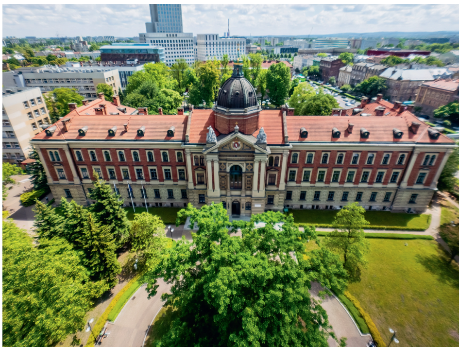
Rycina 1. Budynek Schroniska fundacji księcia Aleksandra Lubomirskiego (stan obecny)
